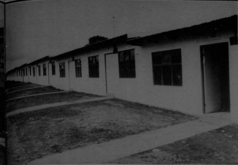
Uno de los proyectos que la Constructora San Antonio S.A. está por terminar es la urbanización El Cerro de los Indios, la cual consta de 50 casas de habitación. (Carrillo)
