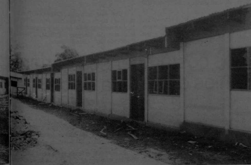
El sistema prefabricado se está utilizando en algunas de las viviendas de la Urbanización El Cerro de los Indios. (Carrillo)
